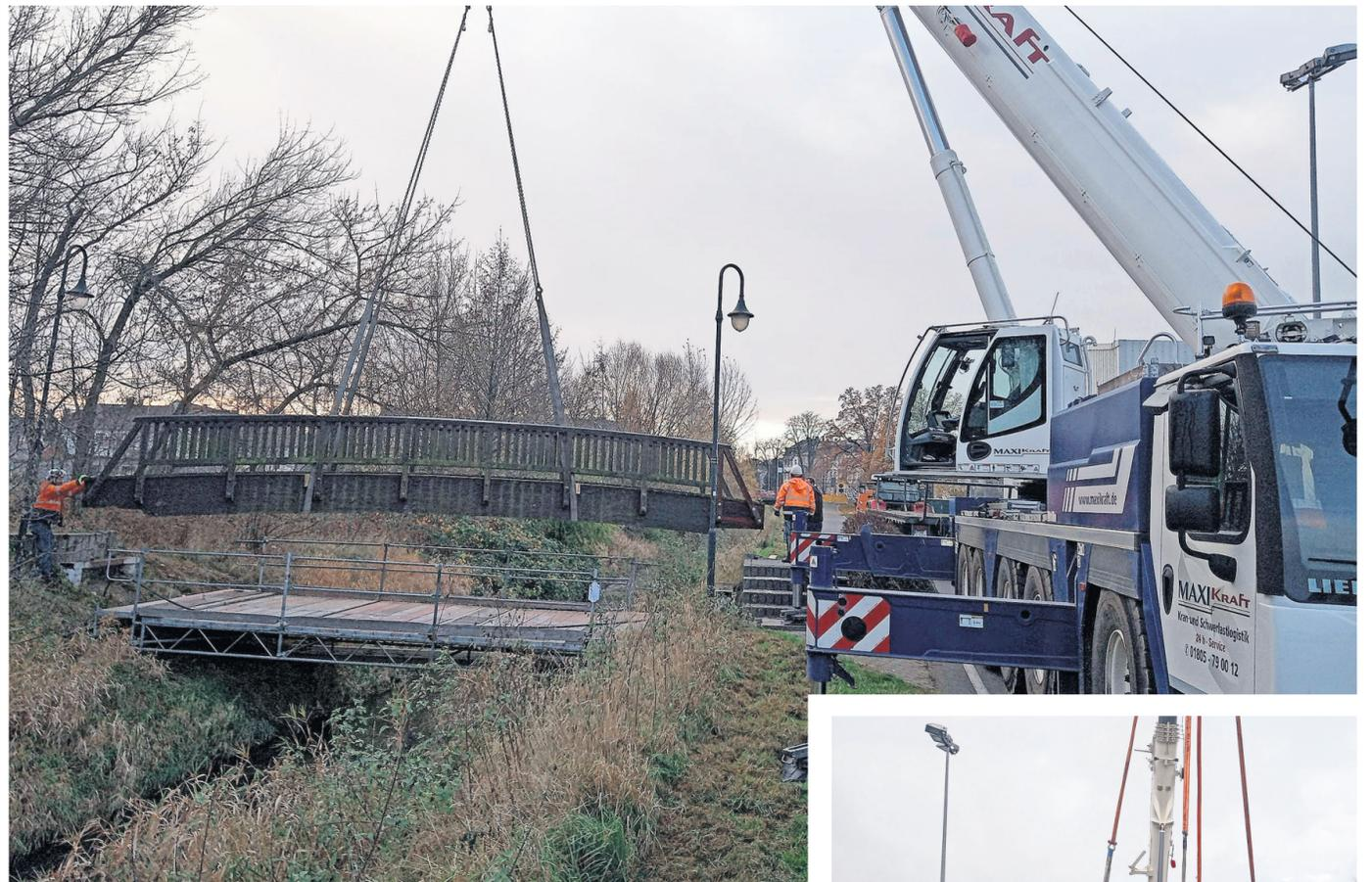
Die alte Holzbrücke wird entfernt (oben) und durch eine moderne Stahlbetonbrücke ersetzt.
